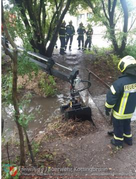
Gegen 11 Uhr des 03.08.2020 wurden wir von der Gemeinde zu Hilfe gerufen, da sich im Bereich der Eichengasse der Schanzbach aufgrund einer Verklausung staute. Mittels Schalengreifer des Wechselladefahrzeuges wurde die Verklausung entfernt und der Schanzbach konnte seinen gewohnten Weg wieder fließen.
