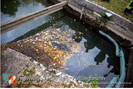
Nach dem Schadstoffeinsatz am 02.11.2016 wurde am 03.11.2016 um 08:00 Uhr die zweite Kontrolle der Ölsperren vorgenommen. Von der Strömung wurden abermals Autoteile angeschwemmt. Diese wurden von der Einsatzmannschaft entfernt, ehe wieder eingerückt werden konnte.
